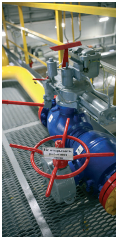
Рис. 1. Элементы технологической части автоматической установки газового пожаротушения МИЖУ
