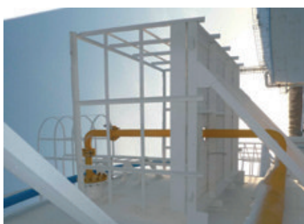
Рис. 1. Элементы технологической части автоматической установки газового пожаротушения МИЖУ
